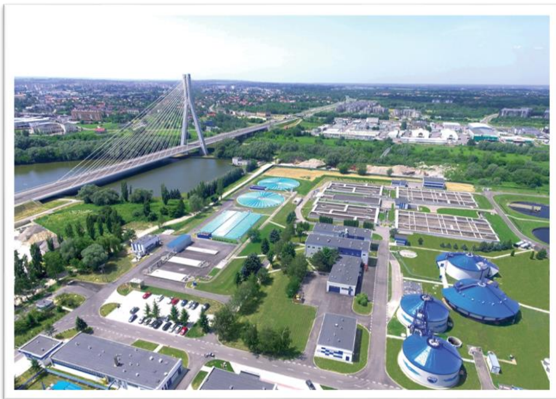
Oczyszczalnia Ścieków w Rzeszowie
